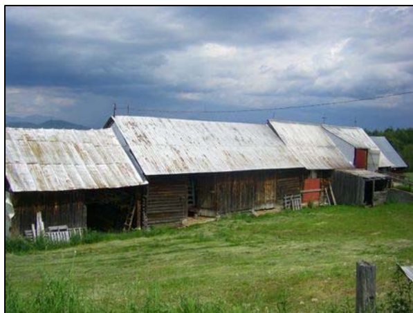
Bâtiment-bloc visible au 19, rue Notre-Dame, Notre-Dame-des-Monts.
