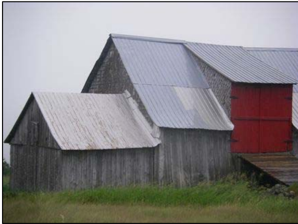
Mur-pignon d'une grange-étable recouvert de bardeaux de cèdre, situé au 1830, côte Bellevue, La Malbaie.
