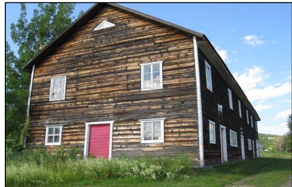
Bâtiment agricole en planches à feuillures, localisé au 765, boulevard Malcolm-Fraser, La Malbaie (Cap-à-l'Aigle).
