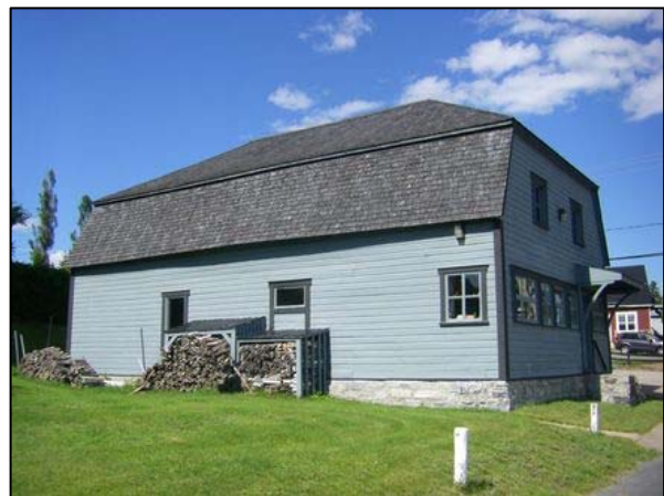
Bâtiment agricole dont la toiture est entièrement recouverte de bardeaux de cèdre, localisé au 290, rue Principale, Saint-Irénée.
