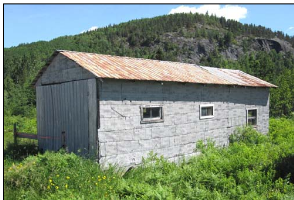
Garage recouvert partiellement de papier goudronné imitant la pierre, situé sur le chemin du Port-aux-Quilles, Saint-Siméon (Port-aux-Quilles)
