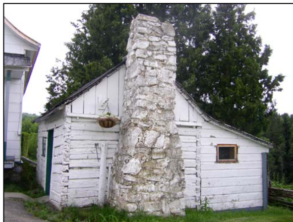
Cheminée en maçonnerie accolée à un fournil localisé au 460, rang Saint-Charles, La Malbaie
