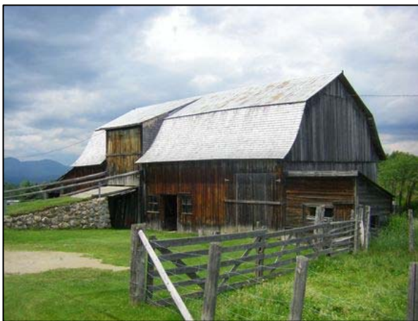
Le brisis de la toiture est recouvert de bardeau de cèdre. Grange-étable située à la gauche du 115, rue Notre-Dame, Notre-Dame-des-Monts.
