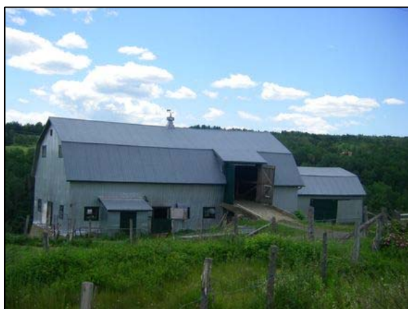
Grange-étable située au 70, chemin du Gros-Ruisseau, La Malbaie.
