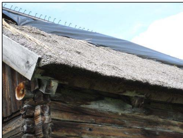
Détail de la toiture de chaume de la grange-étable Bhérer, localisée au 215-219, rue Saint-Raphaël, La Malbaie (Cap-à-l'Aigle)
