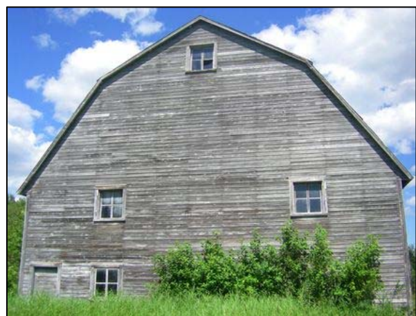
Grange-étable recouverte de planches à clins, située au 35, chemin Principal, Saint-Irénée.
