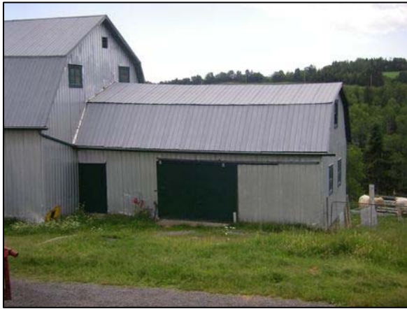
Grange-étable sise au 70, chemin du Gros-Ruisseau, La Malbaie (Pointe-au-Pic).
