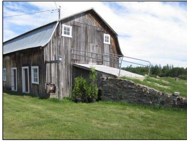
Garnaud en maçonnerie menant à l'étage des combles (fenil) de la grange-étable sise au 510, route de la Grande-Alliance, Baie-Sainte-Catherine.
