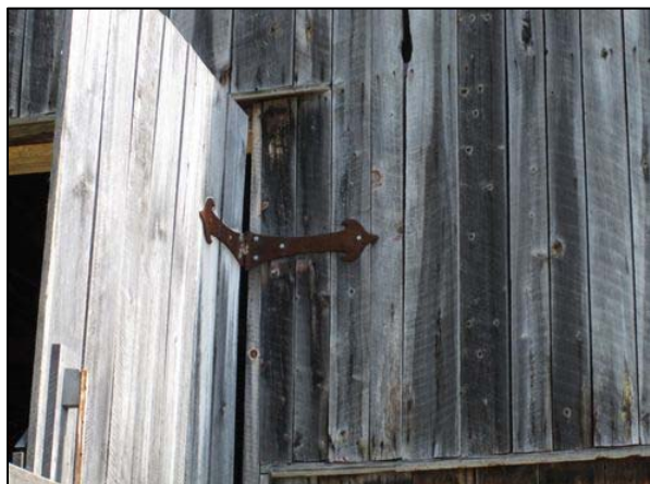
Ferrures d'une porte à battant, observable sur la grange-étable sise au 309, chemin de l'Anse-au-Sac, Saint-Irénée.
