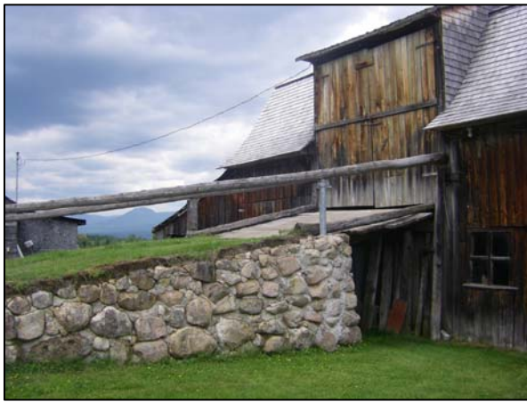
Garnaud en maçonnerie et pont d'accès en bois aménagés sur la grange-étable sise au 115, rue Notre-Dame, Notre-Dame-des-Monts.
