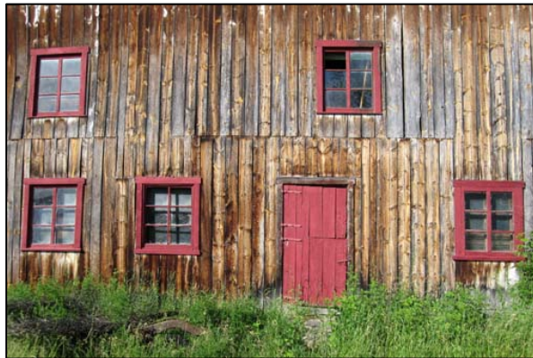
Porte piétonne et fenêtres visibles sur la façade latérale de la grange-étable située au 49, chemin des Lacs, Clermont.
