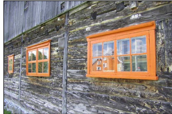
Fenêtres perçant la façade latérale de la grange-étable sise au 485, rang Saint-Nicolas, Saint-Irénée.
