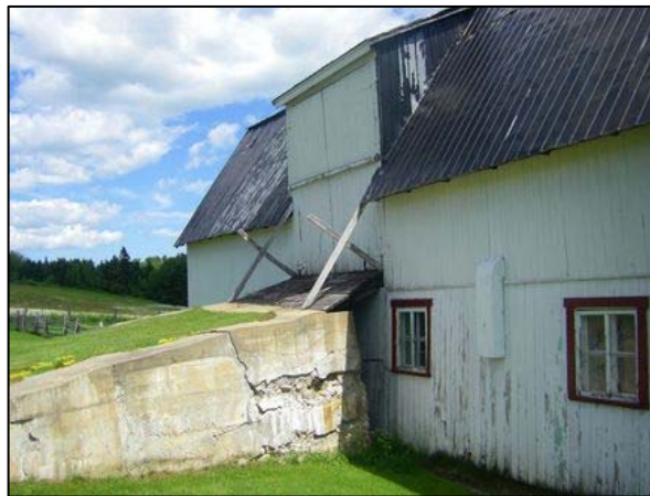
Garnaud en béton et ponceau de bois visibles sur la grange-étable située au 1070, rang Terrebonne, Saint-Irénée.
