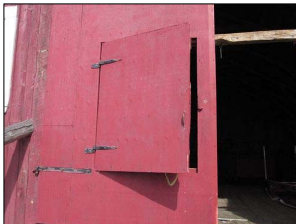
Guichet pratiqué dans l'une des portes à battants de la grange-étable située au 440, route de la Grande-Alliance, Baie-Sainte-Catherine.
