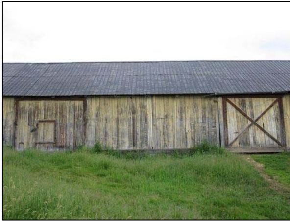
Portes coulissantes dont l'une comporte un guichet (à gauche), visible sur la grange-étable située au 400, rang Saint-Antoine, Saint-Irénée.
