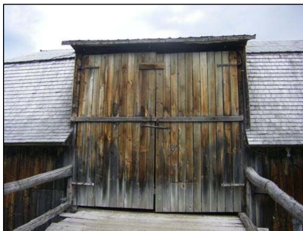
Portes à battants visibles sur la grange-étable localisée à la gauche du 115, rue Notre-Dame, Notre-Dame-des-Monts.
