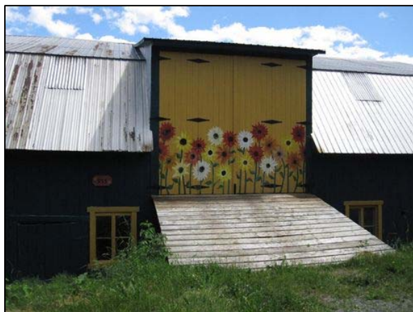
Garnaud en bois menant à la batterie de la grange-étable située au 955, chemin de Port-au-Persil, Saint-Siméon (Port-au-Persil).
