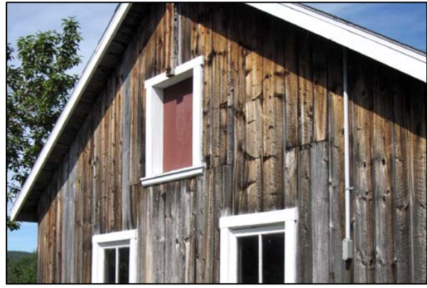
Trappe d'accès aménagée dans le mur pignon d'un bâtiment agricole situé au 510, route de la Grande-Alliance, Baie-Sainte-Catherine.
