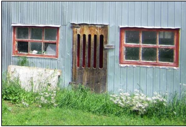
Porte d'étable dotée d'une contre-porte ajourée, visible sur la grange-étable située au 61, chemin du Lac-Nairne, Saint-Aimé-des-Lacs.
