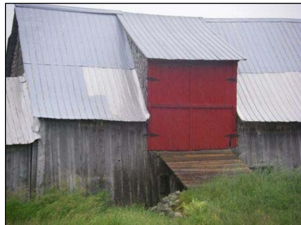
Lucarne de garnaud abritant l'accès à la batterie, visible sur la grange-étable située au 1830, côte Bellevue, La Malbaie (Pointe-au-Pic).
