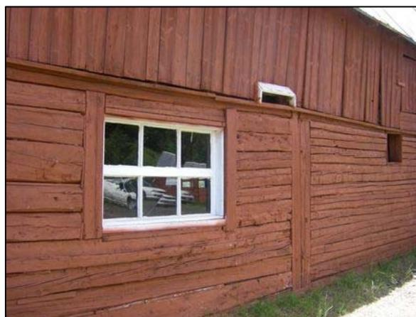
Portion de mur du rez-de-chaussée assemblé selon la technique de tenons à coulisses, visible sur la grange-étable sise au 491, rang Saint-Nicolas, Saint-Irénée.
