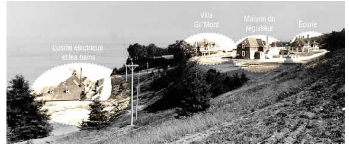
6.13. Le domaine de Rodolphe Forget (sous-secteur 3 – Le Domaine Forget), en 1906. Source : Alain BOUCHER. « 1902 - L'architecte de Gill'mont présente sa création ». 408cm 2 [en ligne] : http://408cm2.canalblog.com/archives/2012/08/10/25141092.html (consulté le 7 octobre 2015).
