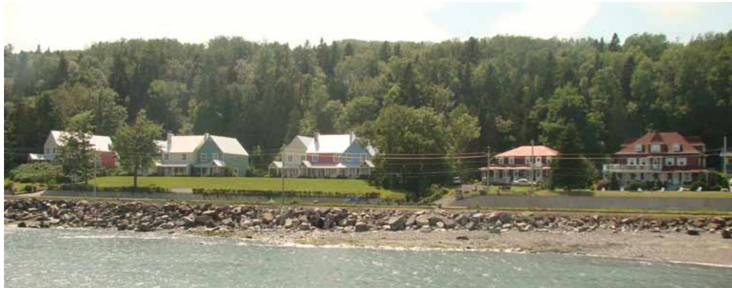
6.41. Le bâti type dans la partie sud du chemin des Bains ( unité de paysage 2.1 – La zone de villégiature ), caractérisé par la présence de maisons cubiques et à mansarde ainsi que des cottages contemporains.
