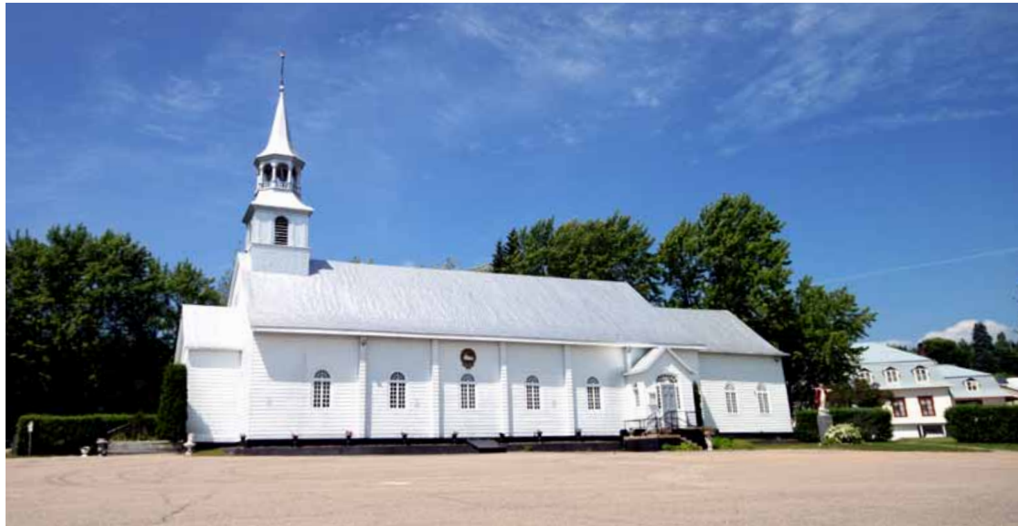
6.86. Le dégagement autour de l'église permet d'ouvrir les perspectives vers celle-ci, le presbytère et le cimetière voisin.
