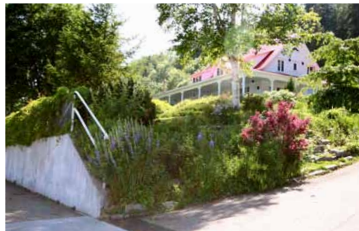
6.59. La villa Les Récifs, en 2013. Le talus et les murets en béton sont omniprésents depuis le chemin des Bains.
