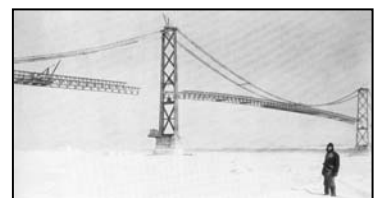
Figure 11. Construction du pont de l'île (1934-1935, J.B. Edwards)
