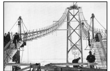
Figure 10. Construction du pont de l'île (1934-1935, J.B. Edwards)
