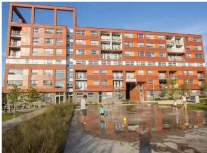
B. Coopérative des Bassins du Havre (Atelier Raouf Boutros)
