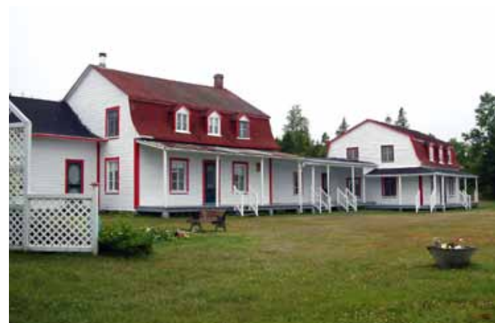
1.21. L'ancien presbytère et la maison Boulianne, reliés par un passage couvert.
