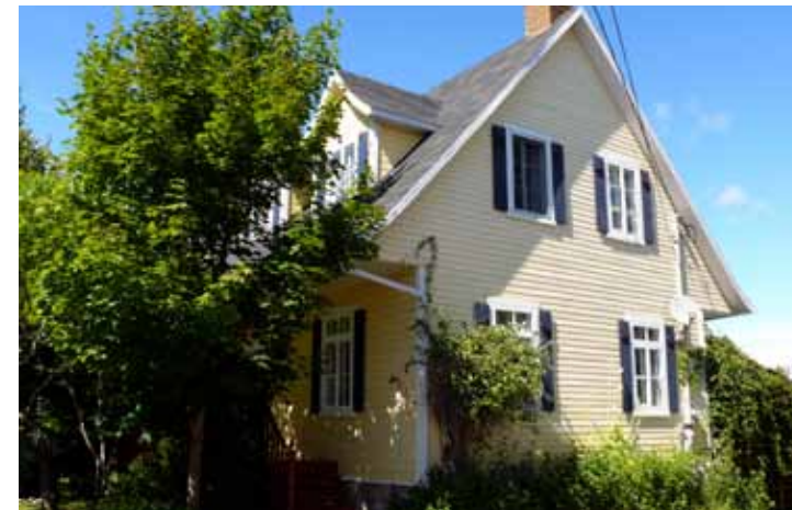
3.57. Maison sise au 101, rue Lapointe, construite en 1940 et qui s'inspire des maisons de compagnie construites auparavant à Clermont.
