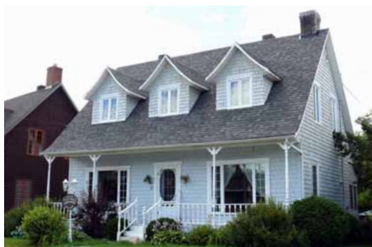
3.46. Résidence construite à partir du modèle « B », sise au 32, rue Maisonneuve.
