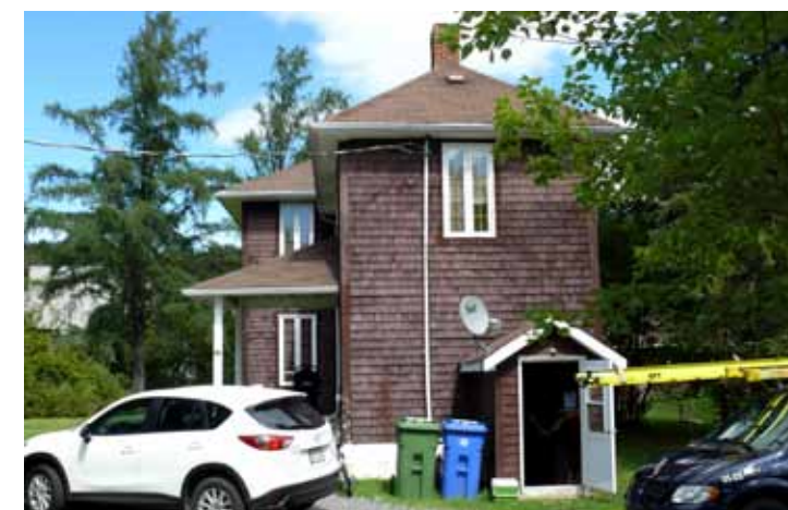
3.51. Résidence construite à partir du modèle n° 1, sise au 95, rue Maisonneuve. Vue de la façade donnant sur la rue Maisonneuve.
