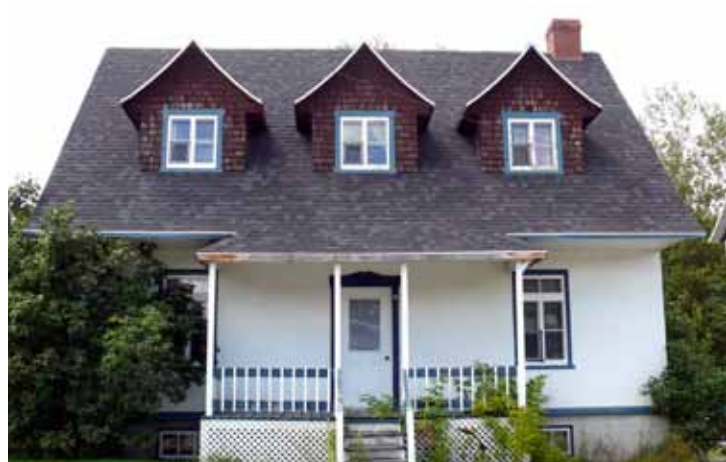
3.45. Résidence construite à partir du modèle « B », sise au 34, rue Maisonneuve.
