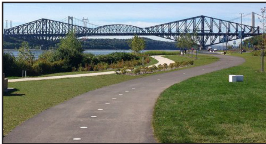
Sentier en béton bitumineux sinueux.
